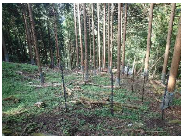
溪畔林整備施工地（白石沢）
