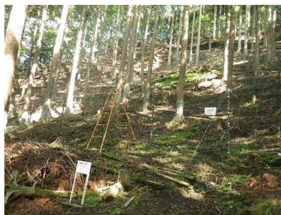
溪畔林整備施工地（白石沢）
