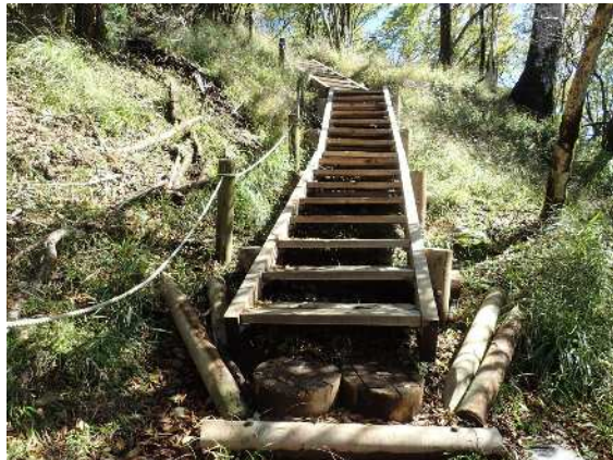
登山道整備状況（丹沢主稜線）：施工後
