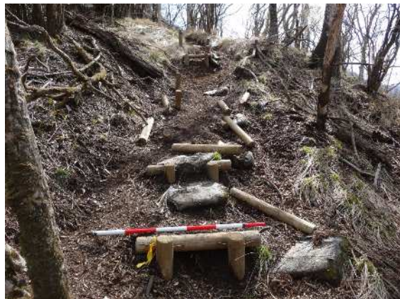
登山道整備状況（丹沢主稜線）：施工前
