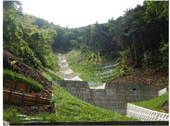
治山工事実施状況（山北町）
