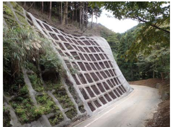
林道改良工事実施状況（唐沢林道）
