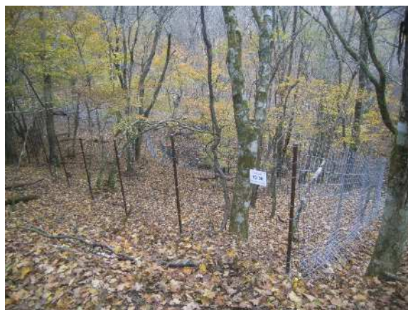
土壌保全工実施箇所（相模原市鳥屋）
