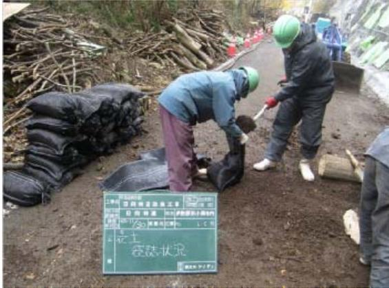
緑化手法試験施工の様子（土壌の袋積み）
