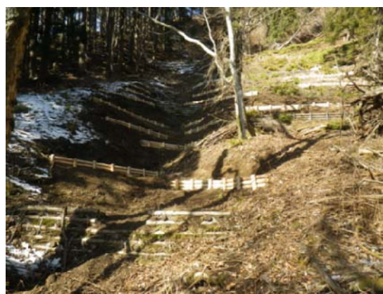
溪畔林整備施工地（仲の沢）
