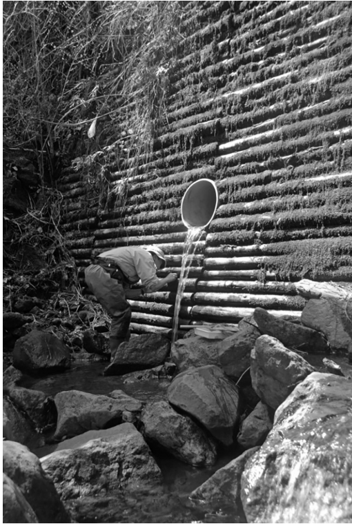
写真2 クラミ沢治山堰（林道橋上）
