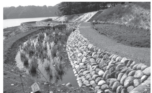
三井地区植物浄化施設
