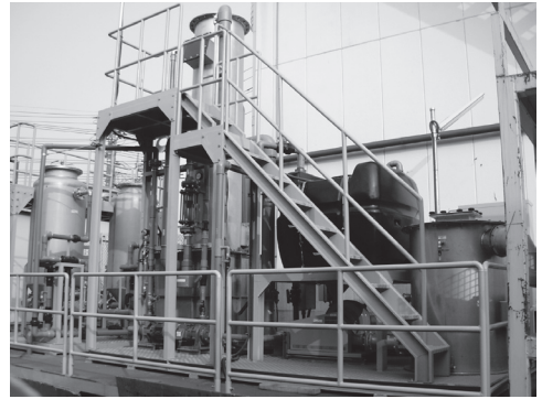
地下水浄化設備（秦野市）
