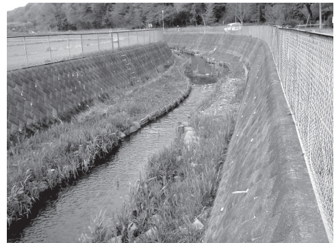
生態系に配慮した水路の整備（厚木市）
