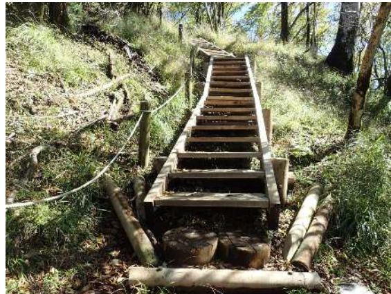
登山道整備状況（丹沢主稜線）：施工後
