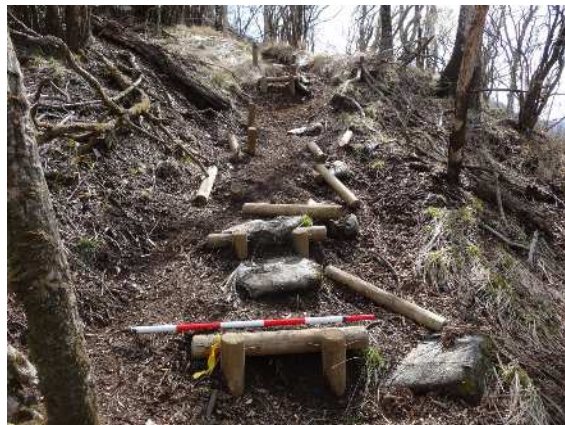
登山道整備状況（丹沢主稜線）：施工前
