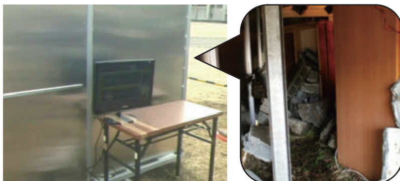
がれき施設とその内部の様子
