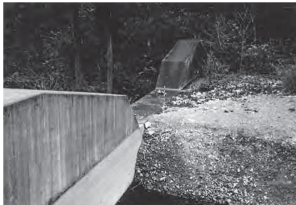
写真3 1991年1月の谷止工の堆砂状況 (1982年度施工の最上流の谷止工)
