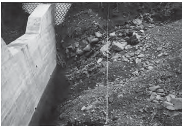
写真2 1983年2月の谷止工の堆砂状況 (上：1982年度施工の上流から2番目の谷止工、 下：1982年度施工の最上流の谷止工)
