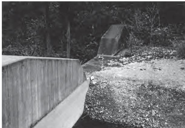
写真3 1991年1月の谷止工の堆砂状況
