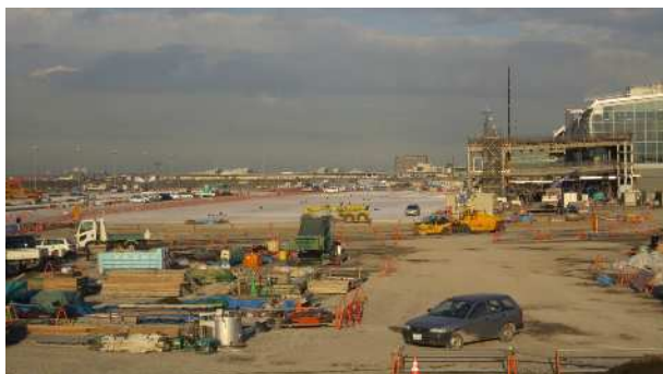
3 スポット分のエプロン新設工事が進む（H25.11 月撮影）
