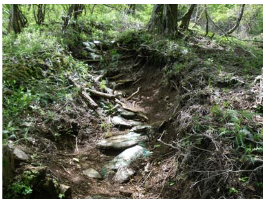
登山道整備状況（丹沢主稜線）：施工前
