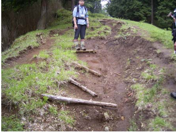
協働による登山道補修状況（菩提峠ヤビツ峠線）：施工前
