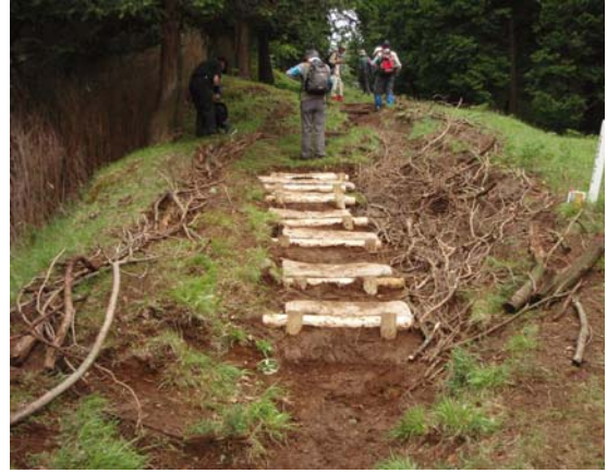
協働による登山道補修状況（菩提峠ヤビツ峠線）：施工後
