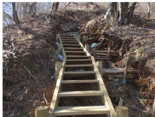
登山道整備状況（丹沢主稜線）：施工後
