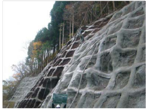
緑化手法試験施工の様子（法枠内吹きつけ）
