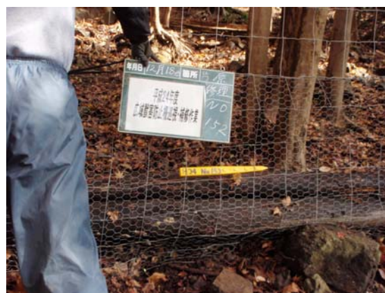
広域獣害防止柵補修状況（清川村）：施工後
