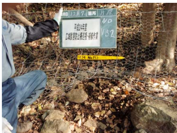
広域獣害防止柵補修状況（清川村）：施工前
