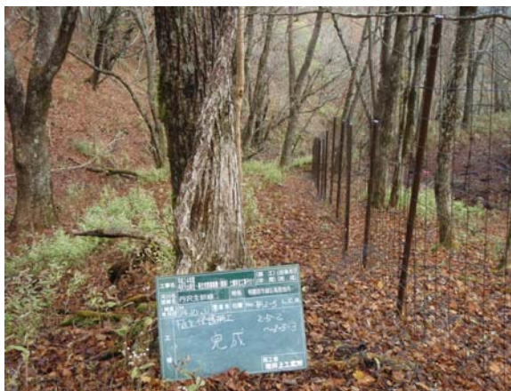
植生保護柵施工箇所（蛭ヶ岳周辺）
