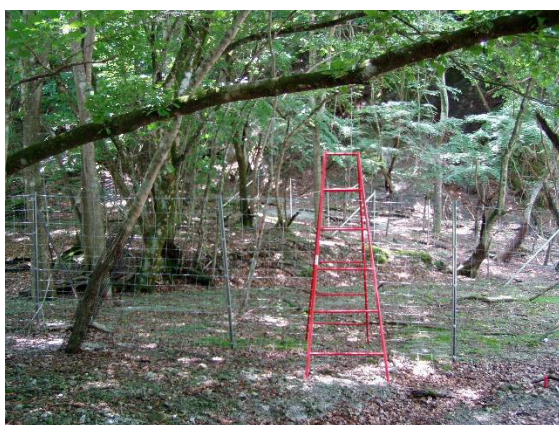
植生保護柵の設置
