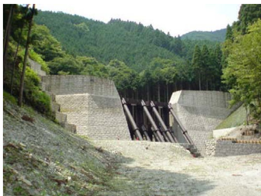
細川沢砂防えん堤(山北町中川)
