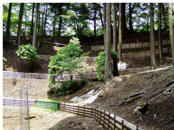
丸太柵工の設置
