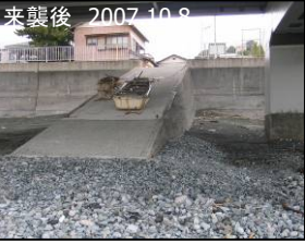
二宮漁港～森戸川間の斜路 斜路の右側(東側)側面に礫が堆積しているのは、西向き沿岸漂砂が卓越していたことを意味する。
