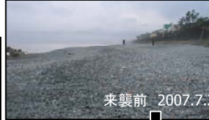
二宮漁港西側 礫浜が広がる。台風来襲後は、道路擁壁基部の根固ブロックが露出した。
