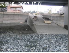
二宮漁港～森戸川間の斜路 斜路の右側(東側)側面に礫が堆積しているのは、西向き沿岸漂砂が卓越していたことを意味する。
