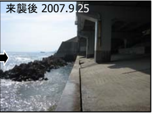
金波橋周辺の被災 台風来襲2日前までは、幅30m程度の砂浜が広がっていたが、来襲後は、橋脚の基礎が露出し、砂浜が完全に無くなった。
