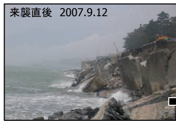
銀波橋周辺の被災 台風来襲により、砂浜が完全に無くなり、海岸護岸等が被災(倒壊)した。来襲後も砂浜は戻らない
