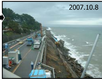
銀波橋周辺の被災 台風来襲により、砂浜が完全に無くなり、海岸護岸等が被災(倒壊)した。来襲後も砂浜は戻らない
