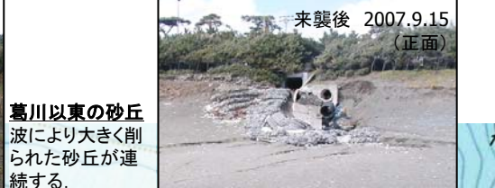
大磯港～岩盤間の排水施設周辺 東寄りの来襲波により排水施設周辺が大きく侵食された。
