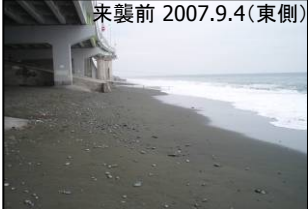
金波橋周辺の被災 台風来襲2日前までは、幅30m程度の砂浜が広がっていたが、来襲後は、橋脚の基礎が露出し、砂浜が完全に無くなった。
