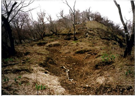
H20丹沢主稜線（施工前）
