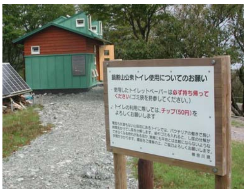
鍋割山公衆トイレ(全景)
