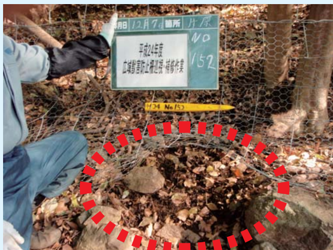
広域柵破損箇所の維持補修の実施状況 (補修前) ※イノシシなどにより潜り込まれた状況
