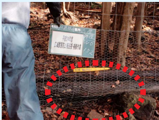
広域柵破損箇所の維持補修の実施状況 (補修後) ※潜り込まれないように丸太を設置
