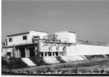
▲排水処理施設
