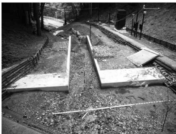
写真5 ヌタノ沢のA沢の量水堰の土砂の堆積状況 (平成23年7月28日撮影)
