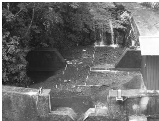
写真7 大洞沢No.1 水文観測地点の量水堰の土砂堆積状況 (平成23年8月8日撮影)
