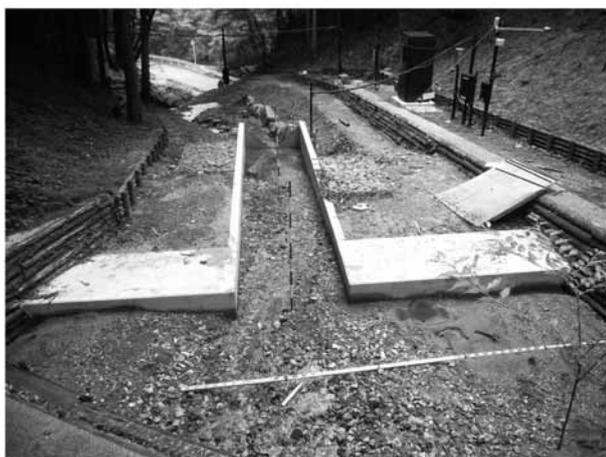
写真5 ヌタノ沢のA沢の量水堰の土砂の堆積状況
