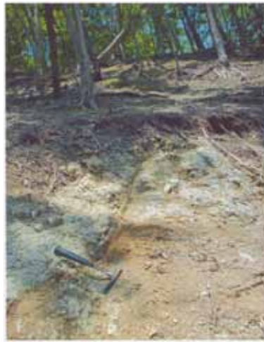
写真7 B沢頂上近くの崩壊部の土壌と基盤岩 （ハンマー位置に節理が認められる）
