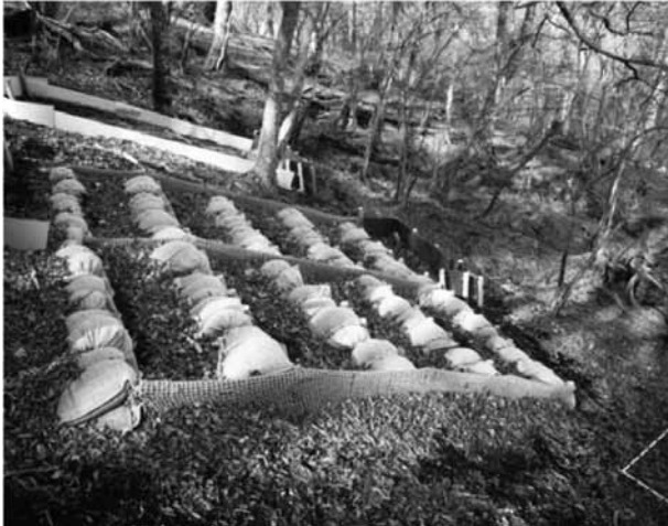
写真3 リター捕捉土嚢工（麻袋）
