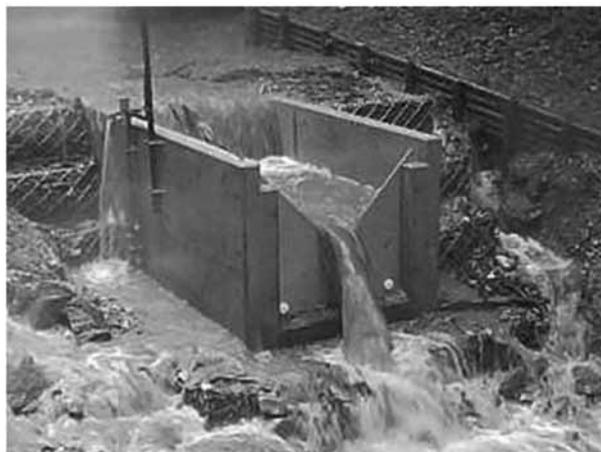
写真6 台風15号の際のヌタノ沢のA沢量水堰の状況
