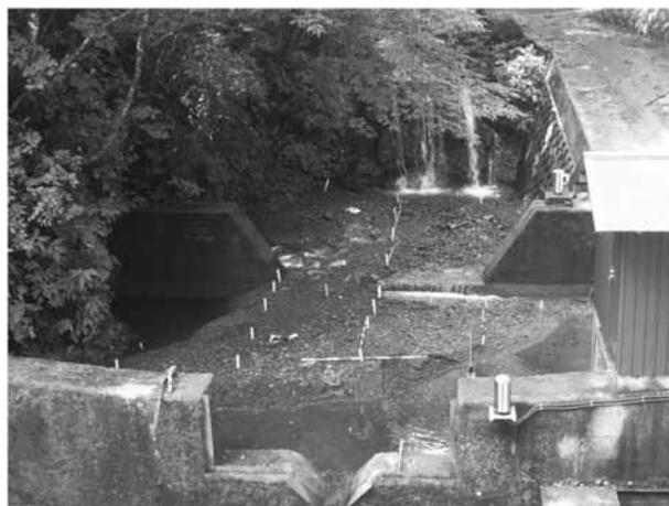
写真7 大洞沢No.1水文観測地点の量水堰の土砂堆積状況
