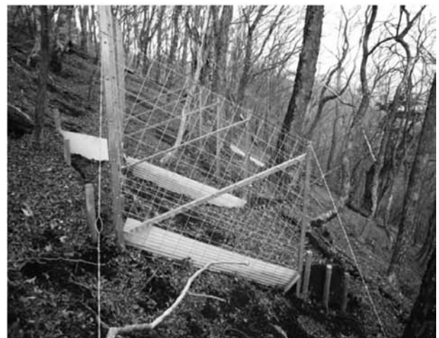
写真5 急斜面用植生保護柵工
