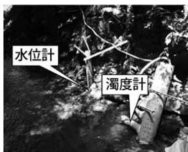
写真2 堂平沢に設置した水位計、濁度計
