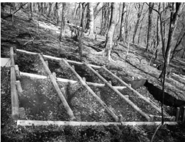
写真4 木製筋工+ネット伏工（竹繊維ネット）
