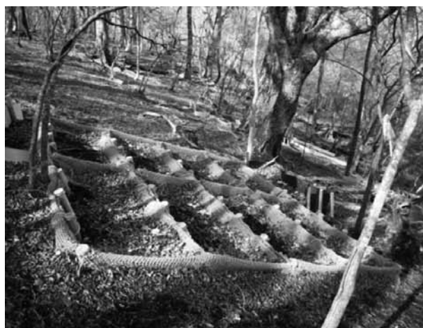
写真2 リターロール工（タイプB）
