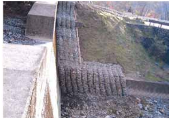
ジャカゴ工設置後
