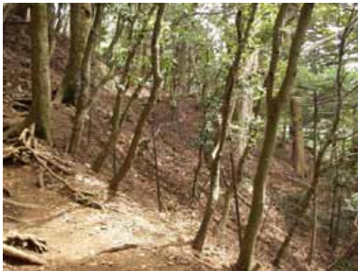
モミ林再生工事（植生保護柵）
