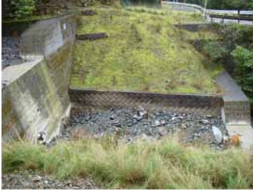
ジャカゴ工設置前
