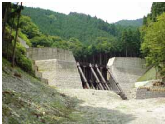
細川沢砂防えん堤(山北町中川)
