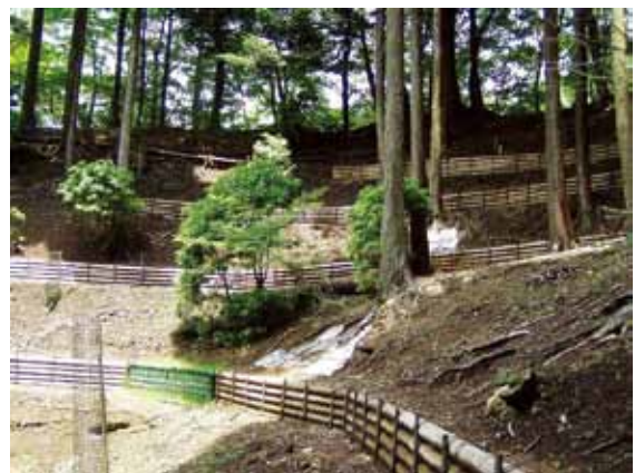
丸太柵工の設置
