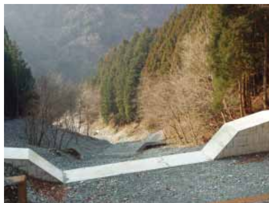
キジゴク沢治山事業(山北町玄倉地内)
