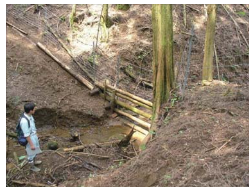
点検・補修した広域獣害防止柵
