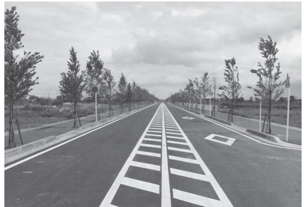
街路樹整備状況(県道711号[小田原松田] 大井町)
