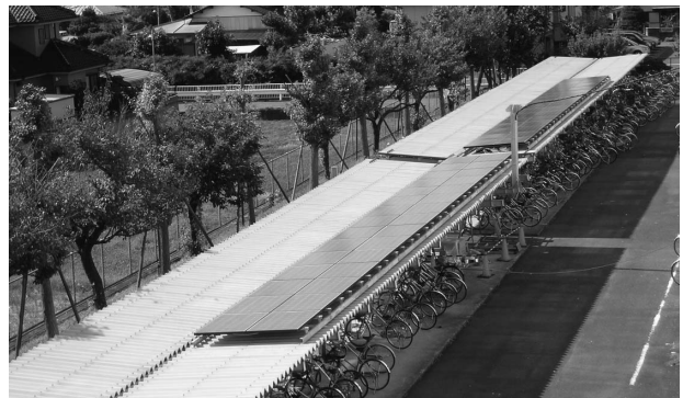
県立海老名高校に導入された太陽光発電システム
