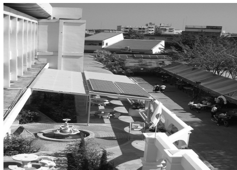
タイの小学校に設置された太陽光発電システム
