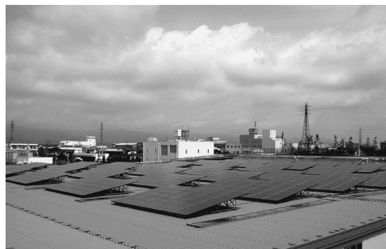
相模川流域下水道右岸処理場に導入された太陽光発電システム
