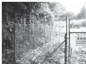
電気柵設置状況
