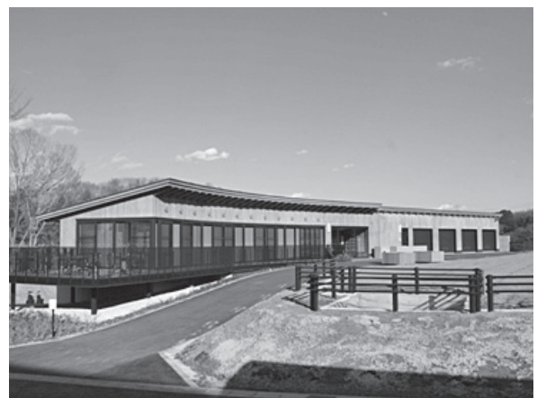
木造公共施設（明治大学黒川農場 川崎市麻生区）
