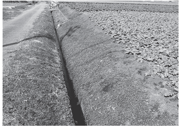
農地からの表土流出防止等のための法面保護活動 （ヒメイワダレ草の植栽 ※小さな白い花が咲きます） （農地・水・環境保全向上対策事業 三浦市初声・仲田元屋敷）
