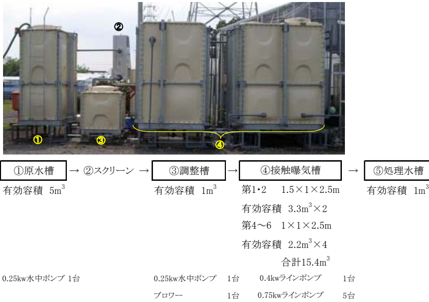
図1 FRP製パネルタンクを用いた浄化システムの概要
