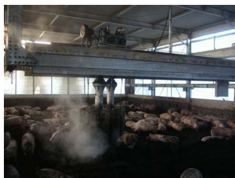
写真1 攪拌中の攪拌機の様子
