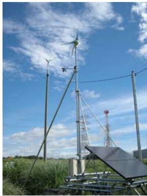
図1 場内に設置した風力発電機及び太陽光パネル
