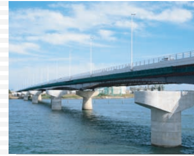
国道134号湘南大橋の4車線化 (茅ヶ崎市~平塚市)
