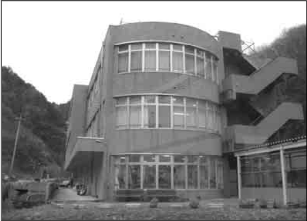
【上川病院の外観】
