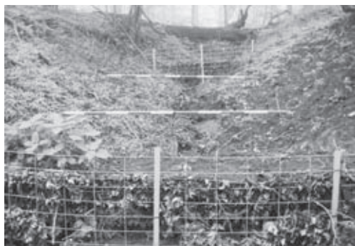
土壌流出防止対策工
