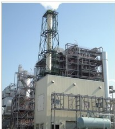
川崎バイオマス発電所(33,000kW) (出典)川崎バイオマス発電所提供
