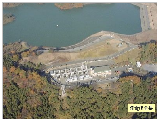
県企業庁・城山発電所
