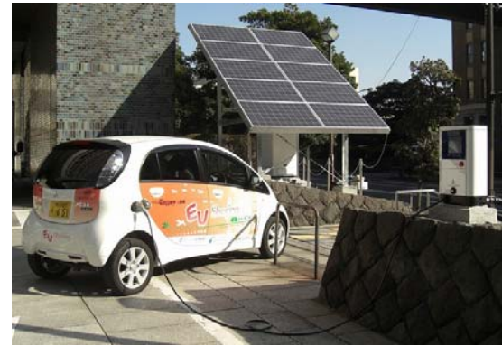
太陽光発電と蓄電池を活用したEV充電システム(県庁)
