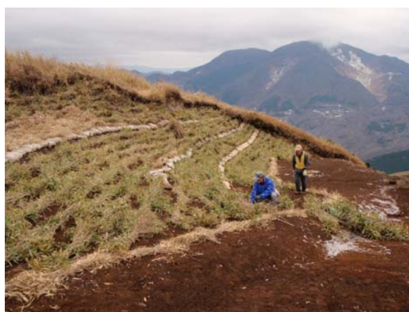
写真2 笹束による植生復元基盤づくり
