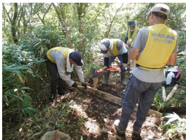
写真1 水切りの設置状況
