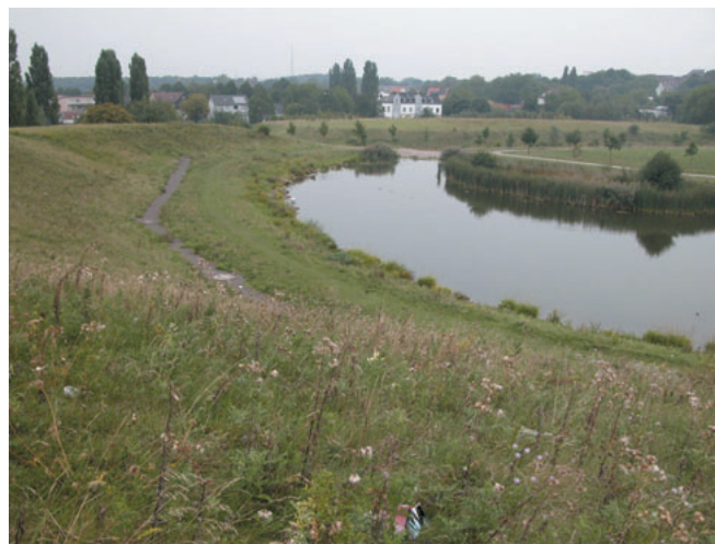
コンパクトシティの例2：採炭場の跡地 残土を盛り上げながら土造成をし、敷地の半分以上に水辺、草地等を確保して工場を誘致している。
