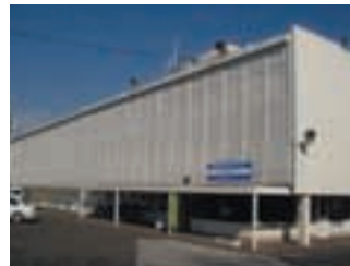
工場を包む光触媒の膜に散水することにより、水膜の蒸発熱で室内を冷却している
