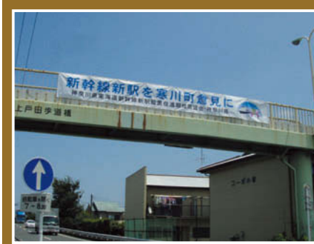
① 上戸田歩道橋 (厚木市内 県道22号)
