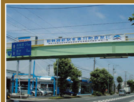
② 神田歩道橋 (平塚市内 国道129号)
