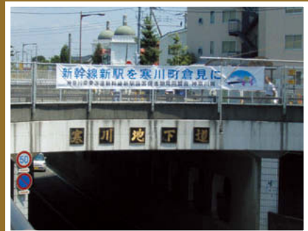
⑤ 寒川地下道 (寒川町内 県道46号)
