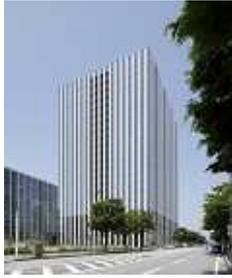
平成22年5月に竣工した複合業務施設「みなとみらいセンタービル」において、自動追尾方式の太陽光採光装置を導入することにより、オフィスフロア共用部中心の吹抜け（エコポイド）を通じて建物内に採光し、昼間照明に用い、併せてエコポイドを通じた排気システムにより、空調負荷や空調動力、換気設備の節減を図った。また、高効率照明器具のスケジュール制御や、窓・外壁の遮熱化・高断熱化、地域冷暖房の導入などの対策を実施するとともに、制振及び免震構造による建物の長寿命化、緑化によるヒートアイランド対策などを実施した。この結果、横浜市建築物環境配慮制度における評価システム「CASBEE横浜」において、最高のSランクであった。
