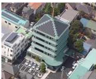
平成20年度に本社工場において、屋根への建材一体型太陽光発電パネル(約20kW)を設置して自社の電力を賄い、余剰電力はバッテリーに蓄電して、照明の一部に導入したLED照明等に用いている。また、自社の技術による冷温水空調蓄熱システムを導入して、冷暖房時に生じる排熱を、冷水槽や温水槽に蓄熱して利用することにより空調を効率化し、年間を通じて電気使用量の削減を図った。さらに、自社のオゾン殺菌処理技術を活用した雨水貯水設備(約200トン)を設置し、冷温水空調蓄熱システムやトイレ排水に使用するなど、複数の対策の連携も行った。これらの対策を講じることにより、1割以上のCO<sub>2</sub>削減を達成した。
