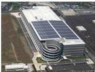
平成21年5月に竣工した賃貸用物流施設「プロロジスパーク座間」において、建物の屋上に1MWの太陽光発電パネルを設置し、年間約110万kWh(一般家庭約300世帯分の年間消費電力に相当)を発電するとともに、PC(プレキャストコンクリート)免震構造の採用による建物の長寿命化や、外壁の高断熱化による空調の効率化、高効率照明の導入などを実施した。この結果、建築物総合環境性能評価システム(CASBEE)において、最高のSランクであった。なお、当該設備は、県内初のメガソーラー発電(出力1MW以上の太陽光発電)設備である。
