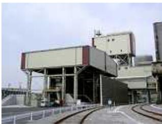
東日本製鉄所・京浜地区において、平成20年に稼働した「新型シャフト炉」の建設において、従来の高炉操業で培った最新センサー技術や排ガス回収技術等を導入することにより、スクラップというリサイクル資源を高いエネルギー効率により再資源化する新たな製鉄技術の開発を行った。「新型シャフト炉」で銑鉄を生産する際に発生するCO<sub>2</sub>は、従来の高炉法による製鉄に比べて、約半分の量に抑えることができる。
