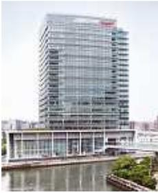
平成21年8月に竣工した「グローバル本社」において、建物中央の吹抜け(ボイド)や2層吹抜け構造を採用し、自然換気による空調の効率化や、自然採光の積極的な利用を図った。また、建物の外部には、高断熱複層ガラスや、高層建築物では類似例がないとされる大型の外装ルーバーを採用した。このルーバーにより太陽熱を反射して、建物表面や地表面の温度を低減しており、空調の効率化と併せて周辺地域のヒートアイランド対策にも貢献している。さらに、地域冷暖房の導入や、積極的な屋上緑化、雨水利用設備などの対策を実施した。この結果、横浜市建築物環境配慮制度における評価システム「CASBEE横浜」において、最高のSランクであった。
