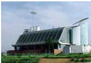
平成22年度に実施した港北ニュータウンビル（通称：アースポート）の改修にあたり、太陽熱集熱器・太陽光発電パネルなどの再生可能エネルギー利用設備や、蓄電池・ガスエンジンコージェネレーションシステムなどの設備を導入し、それらを組み合わせることにより、排熱を効率的に利用して冷暖房を行う高効率空調システムや、電力の統合制御システムなどを構築した。また、自然採光を活用した照明制御システムを導入した。これらの取組により、改修前に比べて約2割のCO<sub>2</sub>削減効果が得られると見込んでいる。
