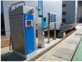
平成22年に、太陽光発電パネルを活用した電気自動車（EV）用急速充電システムを開発した。このシステムは、太陽光発電パネルによる電力を活用し、約25分でEVの容量の約8割を充電できる。また、EVに充電していない時は、他の設備にも電力を供給することが可能であり、電力の使用量の削減によるCO<sub>2</sub>の削減に寄与する。
