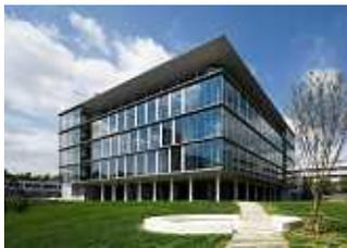
平成22年8月に竣工した「大学中央棟」において、中央部を十字に貫く通路などの採用による自然通風や自然採光、クールピットによる地中熱、井戸水などを利用して、自然エネルギーの積極的な活用を行った。また、高遮熱断熱複層ガラスと障子戸を使い「ダブルスキン」の省エネ手法を応用した縁側の回廊や、屋上緑化庭園などを計画し、建物の断熱性能を向上させ空調負荷の低減を図るとともに、快適な環境を確保した。さらに、高効率の空調換気システムや照明システム、使用状況に応じた外気取入量の制御などを導入した。この結果、横浜市建築物環境配慮制度における評価システム「CASBEE横浜」において、最高のSランクであった。
