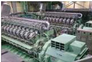
平成19年度から21年度にかけて、ビール類の製造工程においてガスエンジンコージェネレーションシステムを導入し、工場内で使用する電力の全てを賄う（余剰電力は外部に販売）とともに、排熱の回収等により高い総合効率での運転を実現した。また、排水処理工程で発生するバイオガスをガスエンジンの燃料等に活用して燃料使用量を削減するなど、複数の対策の連携を行った。さらに、物流倉庫エリアにおける照明の高効率化等も実施した。工場全体で継続的に省エネ活動を行いつつ、これらの対策を講じることにより、3年間で1万トンを超えるCO<sub>2</sub>削減（2割以上の削減）を達成した。
