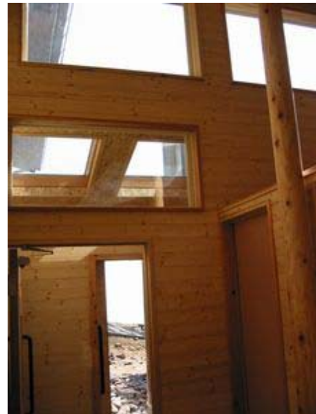
写真5 塔ノ岳公衆トイレ内部
