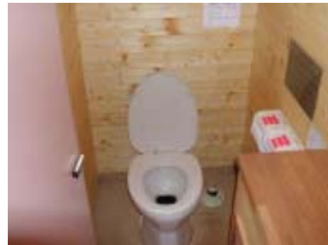
写真6 洋式便器 写真右奥が足踏み式ポンプ
