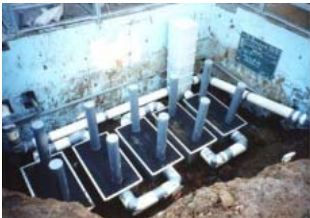
写真8 接触消化槽
