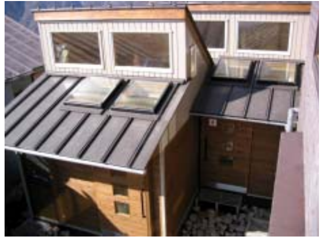
写真4 塔ノ岳公衆トイレ正面
