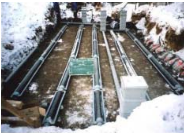
写真9 土壌処理槽 写真はトレンチ管布設状況
