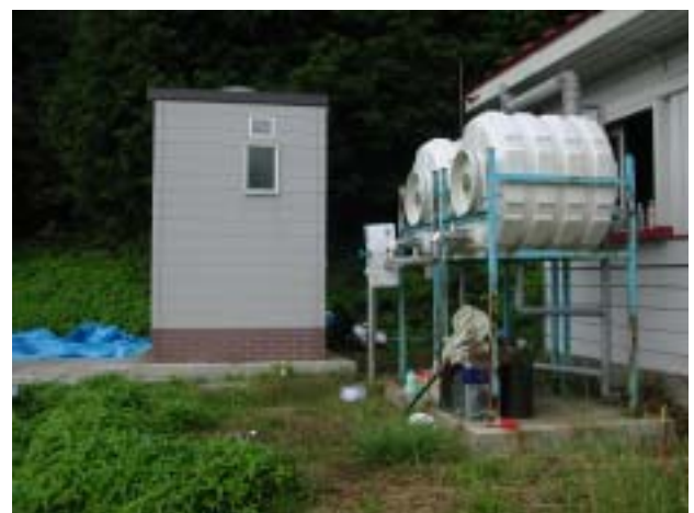
写真2 黍殻避難小屋公衆トイレ 写真右側が雨水を溜めるタンク
