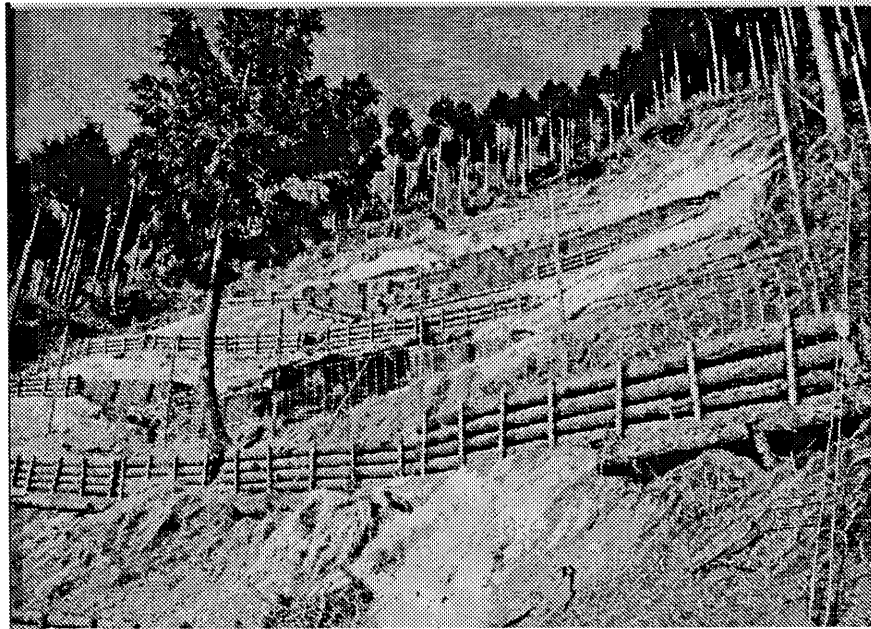
写真9 写真8の崩壊地復旧・施工後の様子(この後、植栽を行う。)
