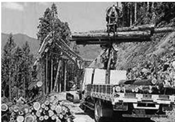
図 5. 高知県 T 町の作業道。路網系からの収穫作業の機械化
