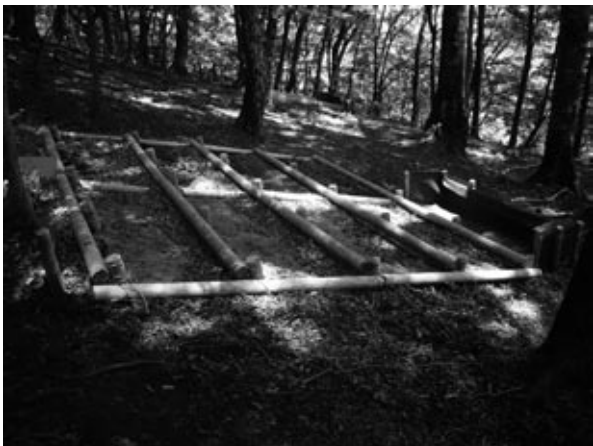
図 8. 木製筋工+ヤシ繊維ネット工 (No.2, 2006 年 8 月 7 日撮影)
