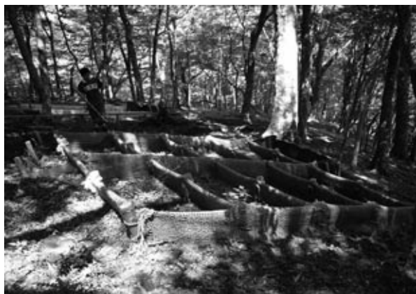
図2.リター捕捉ネット工 (No.20, 2006年8月7日撮影)
