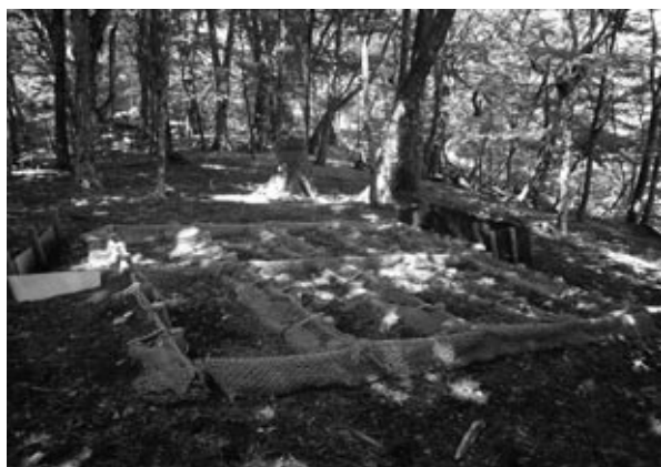
図3.リターロール工 A (リター詰め有り) (No.13, 2006年8月7日撮影)
