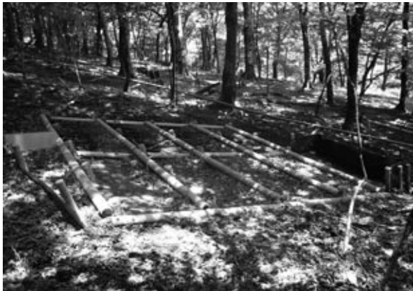
図 7. 木製筋工+竹繊維ネット工 (No.1, 2006 年 8 月 7 日撮影)
