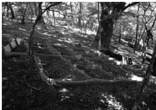
図4.リターロール工 B (リター詰め無し) (No.14, 2006年8月7日撮影)
