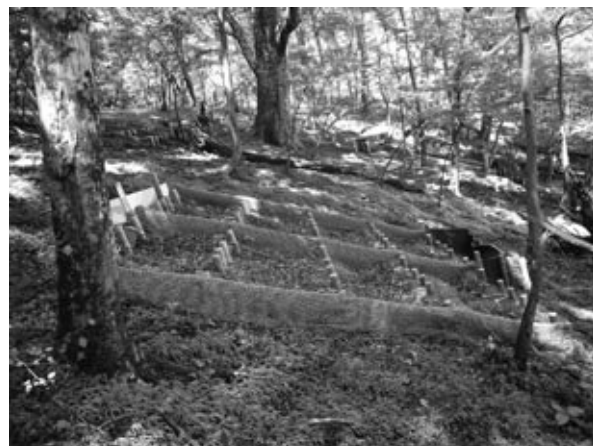
図6.竹繊維袋土嚢工 (No.18, 2006年8月7日撮影)
