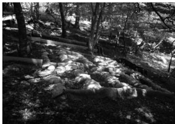
図5.麻袋土嚢工 (No.17, 2006年8月7日撮影)
