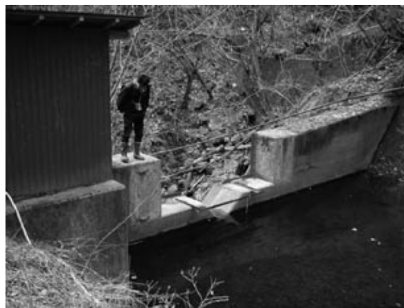
図 4. 量水堰の様子
