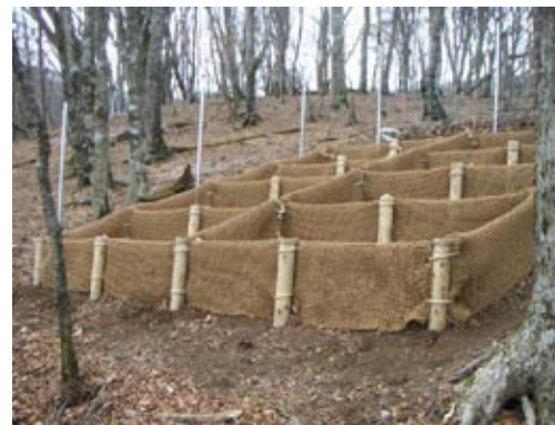
土壌侵食対策手法の試験施工の例（堂平）。左：リターロール工 右：リター捕捉ネット工（第3章第3節IV参照）
