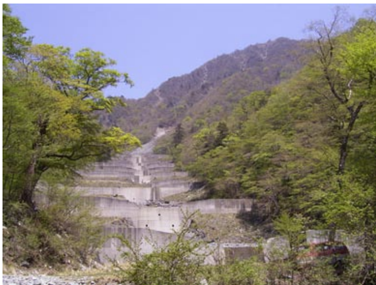
玄倉川流域熊木沢上流の堰堤
