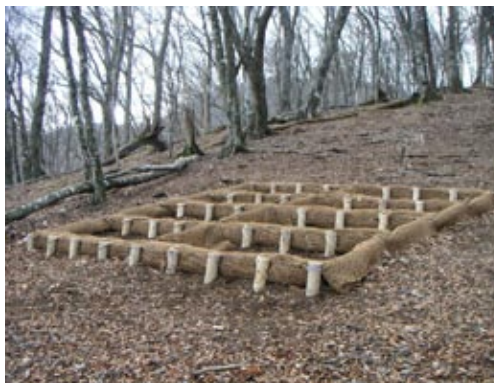
土壌侵食対策手法の試験施工の例（堂平）。左：リターロール工 右：リター捕捉ネット工（第3章第3節IV参照）
